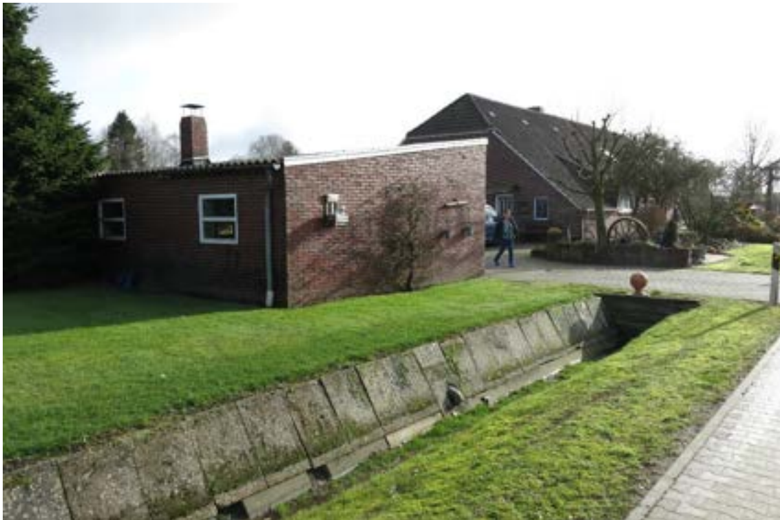
Abbildung 3 Blick von NW auf Wohnhaus und Nebengebäude Unlander Str. 2
