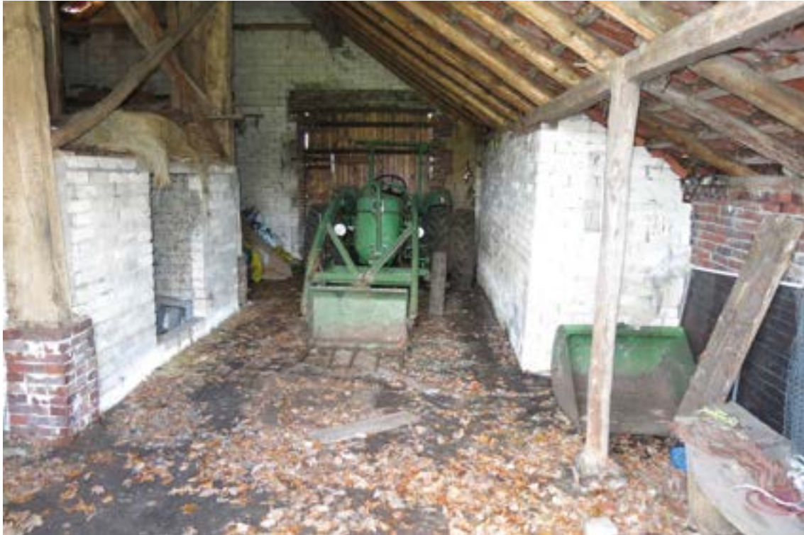
Abbildung 8 Blick in den Schuppen (3) Bild 2
