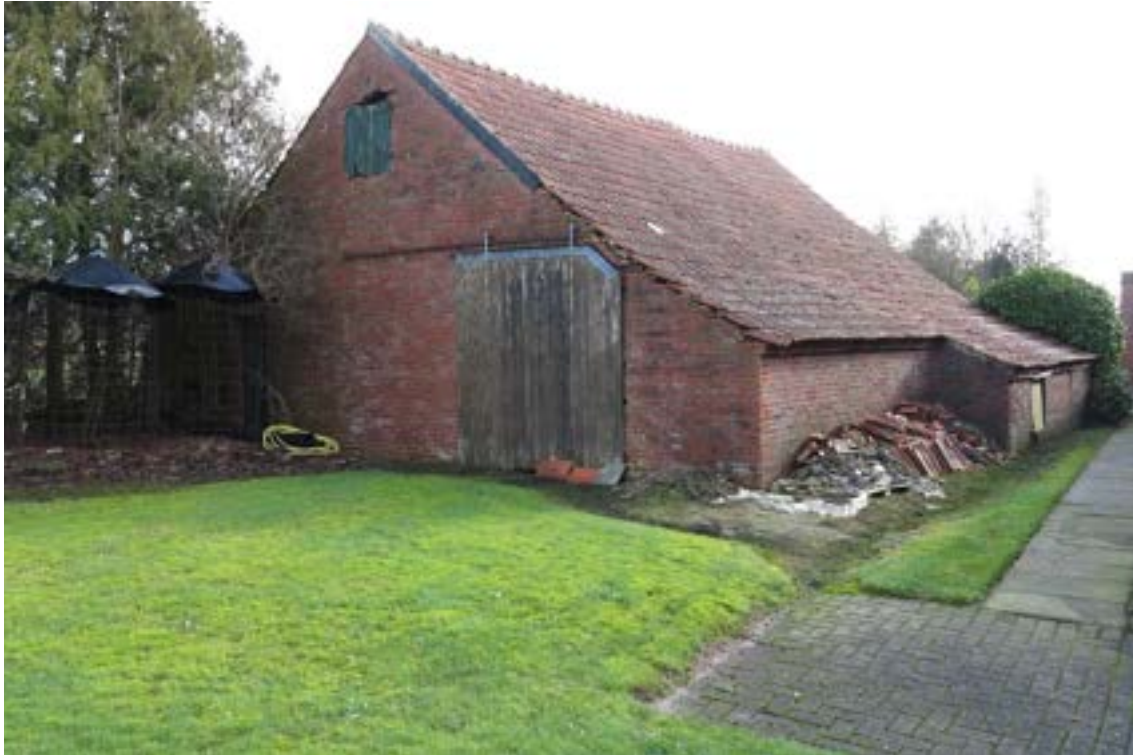
Abbildung 6 Schuppen östlich des Hauptgebäudes (3)
